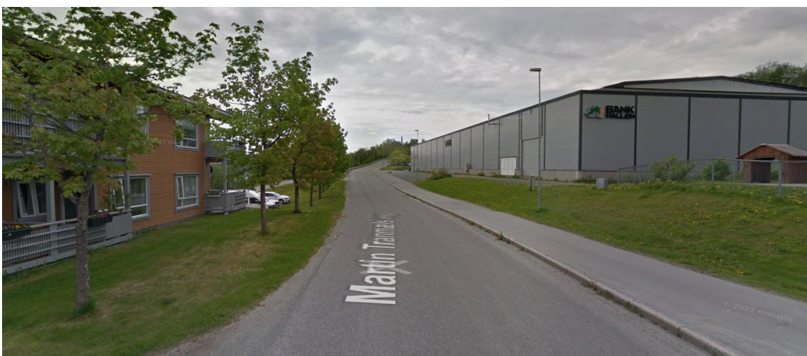
Figur 7 Martin Tranmæls veg sett fra nord. Bankhallen til høyre i bildet (foto: Google).
